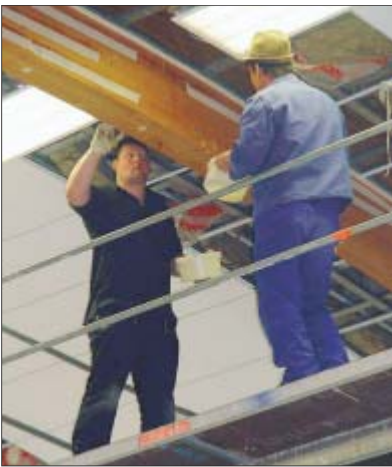
Spezialharz wird in Risse gepresst.
