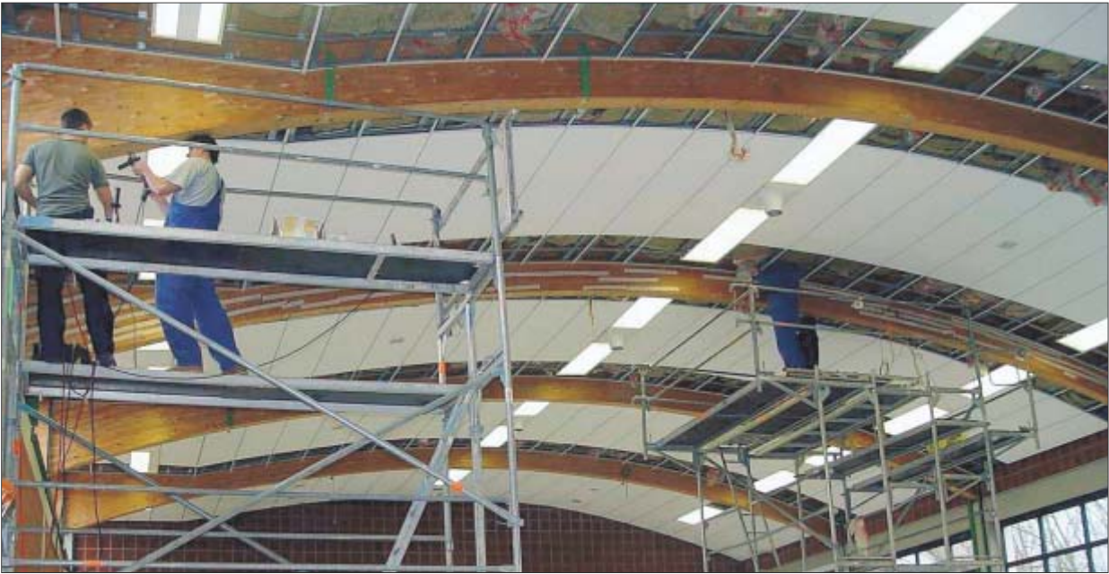
Als Baustelle zeigt sich während der Sanierung an der Tragkonstruktion die Schorn-dorfer Schulturnhalle.
